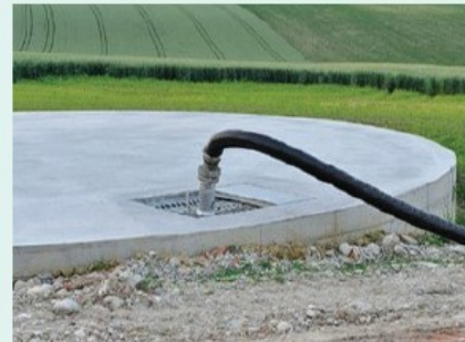
Fosse béton couverte
